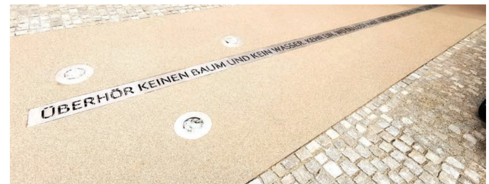
▼ Entwässerungsrinne mit Handke-Zitat Foto: SHARE architects
